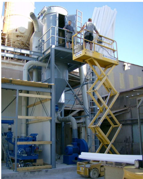
Einbau der Filterschläuche
